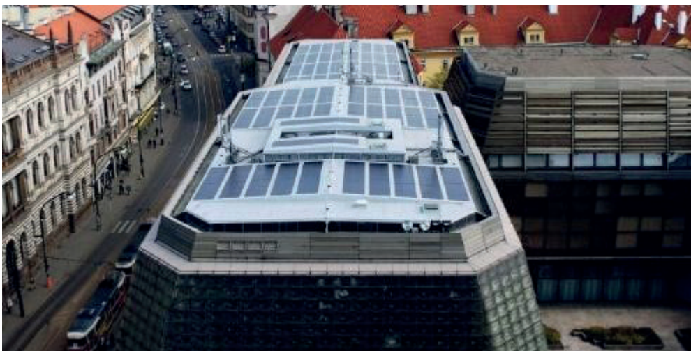
Obrázek č. 10: Fotovoltaická instalace na střeše budovy Nové scény Národního divadla, Zdroj: vtm.e15.cz
